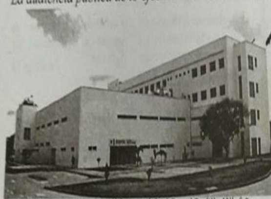
Instalaciones del Hospital Regional José David Padilla Villafañe
